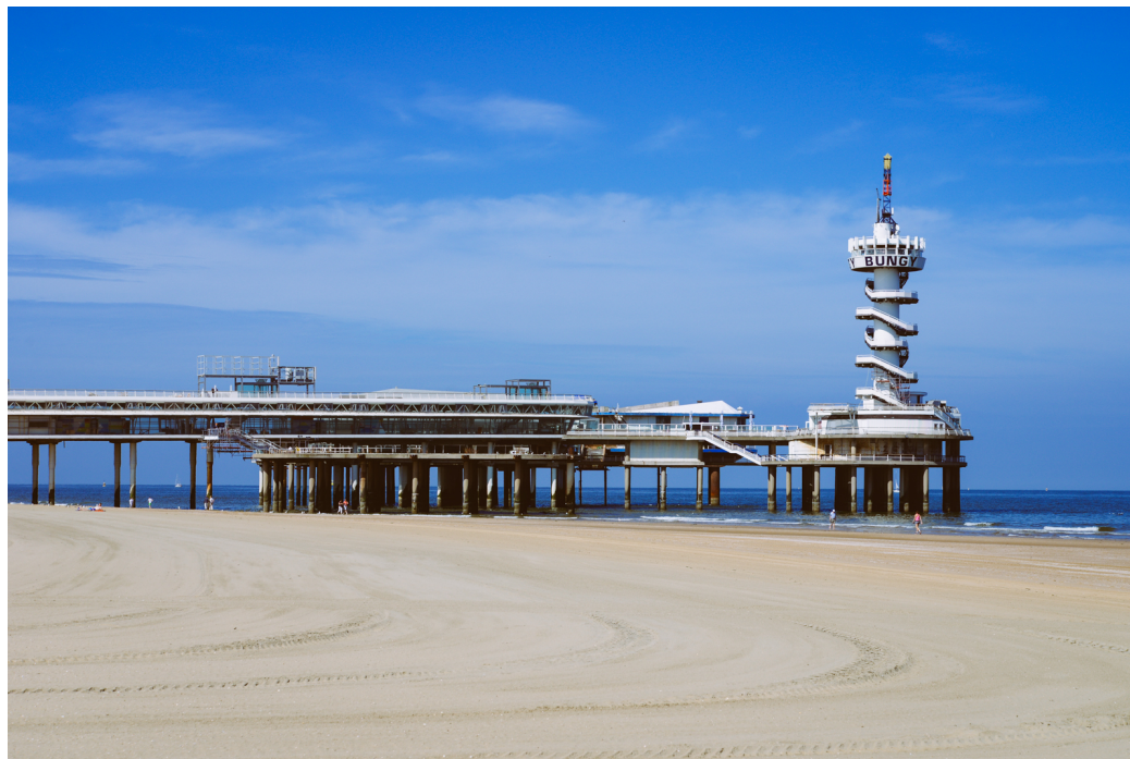
Scheveningen Pier: Local Scour
